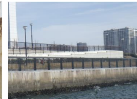
目視点検（船上）
