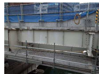
図-3 撤去前の増設縦桁
