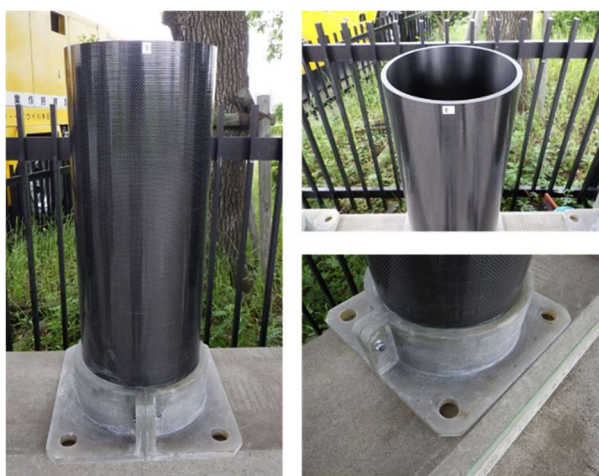
写真-1 CFRP製段差防止構造
