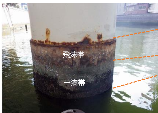
図-2 腐食損傷位置と腐食環境区分の関係
