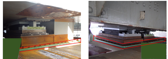
写真-2 支承ベースプレートの拡大化
