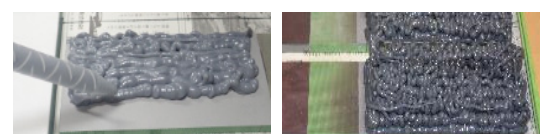
図-3 接着の状況
