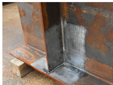
(d) ケレン完了状況
