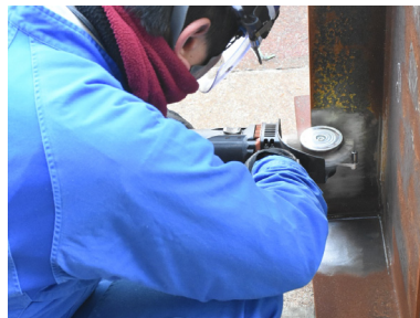
(b) プラスト面形成動力工具によるケレン
