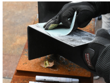
(e) CFRP板表面の目荒らし
