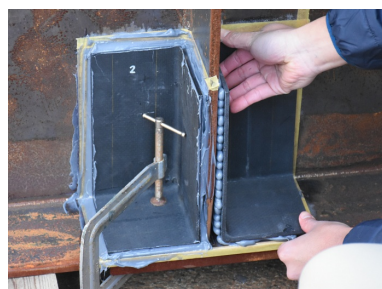
(j) CFRP板の接着
